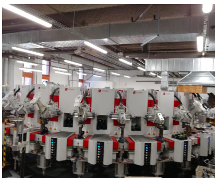
Instalace nového vstříkolisu STEMA
